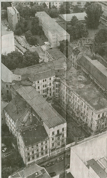
In der Form eines H mit 120 Meter langen Flügeln wurde „Thiemes Hof“ 1875 am Rand des Graphischen Viertels errichtet. Heute bietet er nur noch ein Bild des Jammers.
